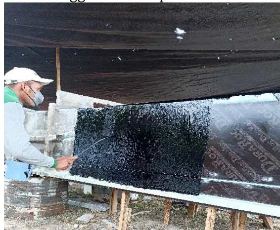
Gambar 3. Proses Penutupan Kerangka Menggunakan Triplek Duraroc
