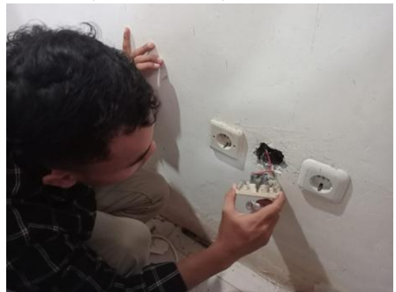
Gambar 5. Perbaikan dan Penerapan Standarisasi Instalasi Listrik di Rumah Mitra
