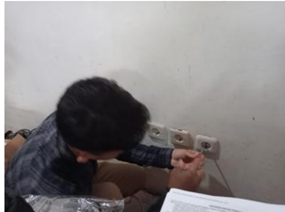
Gambar 4. Hasil Perbaikan Instalasi Listrik sesuai dengan Standar PUIL
