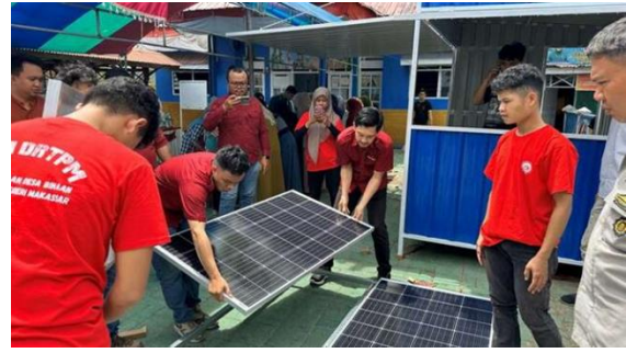
Gambar 6. Proses Perakitan Tenant Box Pendinginan Berbasis Panel Surya
