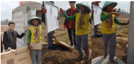
Gambar 5. Pemasangan Panel Surya
