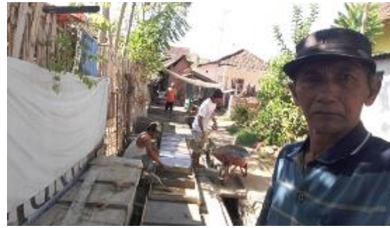
Gambar 5. Proses Pengerjaan Sarana Sanitasi Limbah
