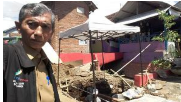
Gambar 6. Proses Pengerjaan Pembuatan MCK Dengan Menggunakan Biofield
