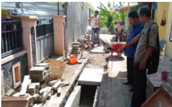
Gambar 4. Proses Awal Pembongkaran Sarana Sanitasi Limbah
