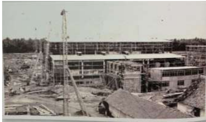
Gambar 3. Proses Pembangunan Pabrik Gula Madukismo dan Pabrik Spirit (Sumber: Pabrik Gula, PS Madukismo)
