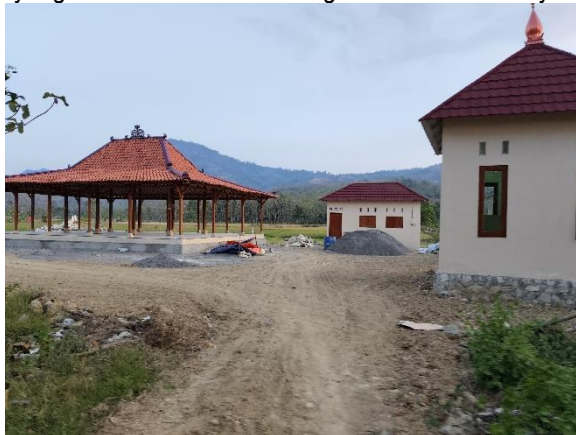
Gambar 3. Foto Pembangunan Rest Area Penunjang Wisata Desa Gentan (dokumen pribadi, 3 Agustus 2024)
