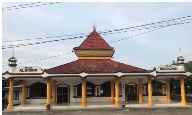
Gambar 1. Masjid Al- Abror (Sumber: Dokumentasi pribadi)
