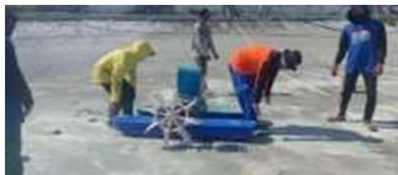
**Gambar 4. Pemasangan Kincir Sistem Pasok Air**
