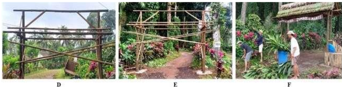
Gambar 3. (d) Pemasangan Gapura Tampak Belakang, (e) Pemasangan Gapura Tampak Depan, (f) Finishing Gapura
