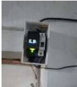
Gambar 3. Pemasangan Smart Power Meter IoT
