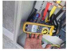
Gambar 4. Pengujian Arus Pada Terminal R
