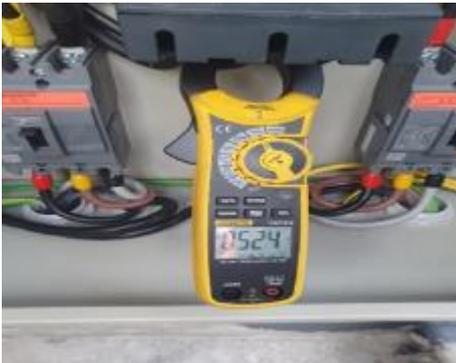
Gambar 6. Pengujian Arus Pada Terminal T
