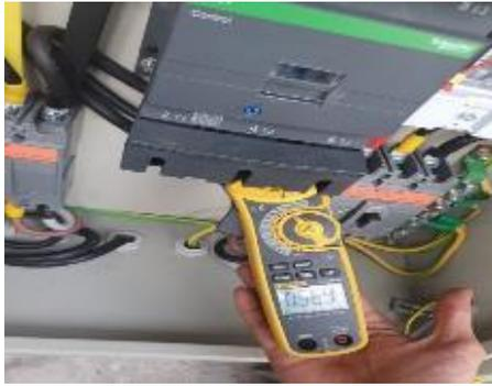
Gambar 5. Pengujian Arus Pada Terminal S
