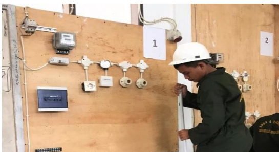
Gambar 4. Rangkaian Praktikum Instalasi Penerangan Listrik di Lab TITL
